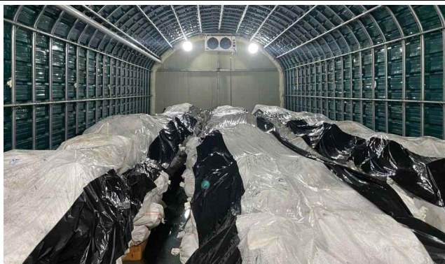
간이버섯재배사 활용 생강저장시설 설치 시범
