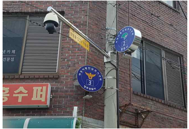
CCTV, 안전 보안등
